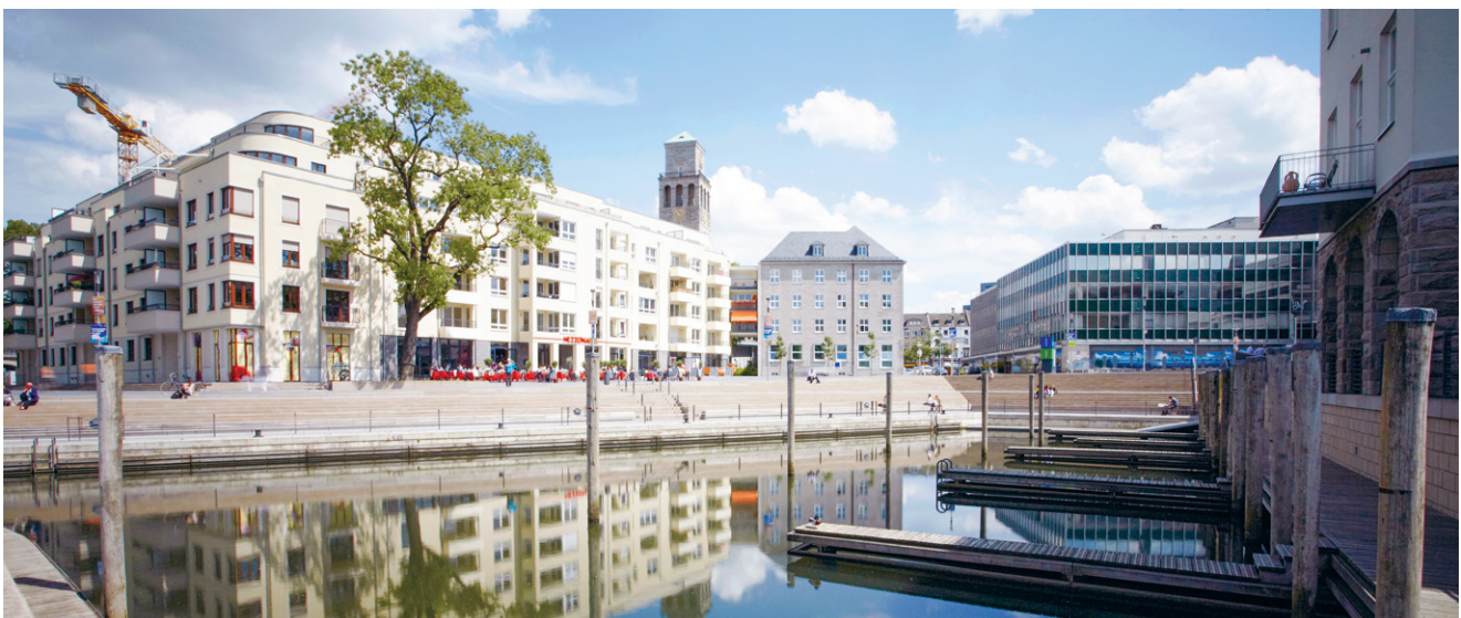
Hafenbecken nach Fertigstellung, Bild Fa. Metten
