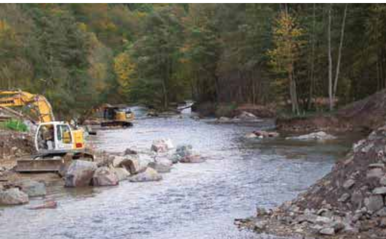
» Baumaßnahmen an der Wupper auf dem Gelände der Firma Vorwerk.
