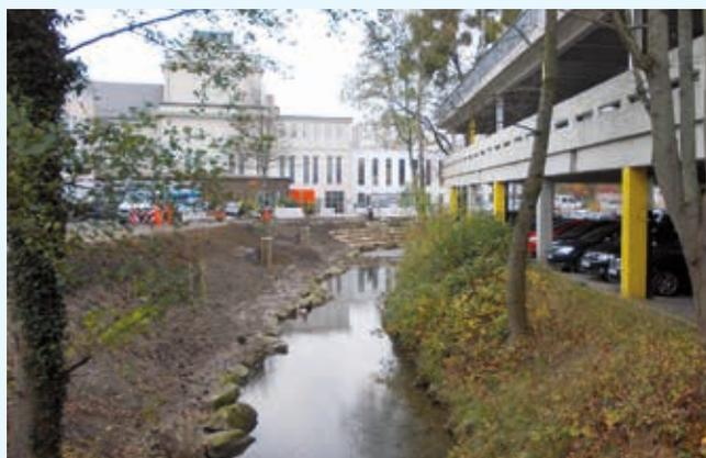
vorher/nachher: Betonverbauungen an der Werre in Detmold wurden entfernt, das Gewässer verbreitert und weitgehend flache Uferböschungen angelegt. Durch große Quadersteine konnte ein Zugang zum Gewässer geschaffen werden. (Quelle: Projekt Wasser im Fluss, AGA)
