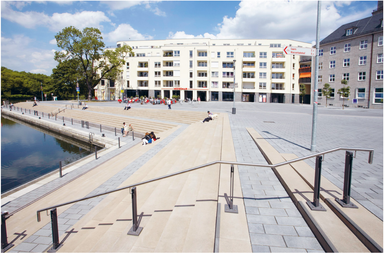
Hafenbecken nach Fertigstellung, Bild Fa. Metten
