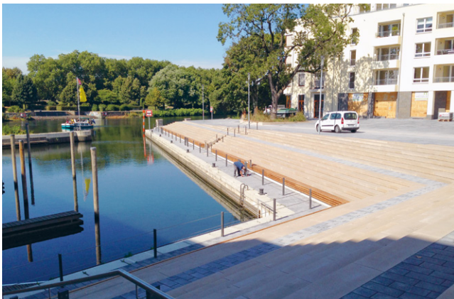
Hafenbecken nach Fertigstellung, Bild Fa. Metten
